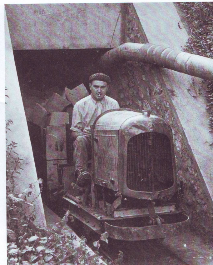
Dans ses bureaux d'études du quai de Javel, André Citroën, n'a certainement jamais imaginé que le capot d'une de ses voitures circulerait plusieurs mètres sous terre au chantier de la Travance. Locotracteur conduit par André Blin.
