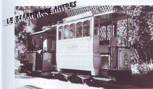
▲ La «Petite» refoule en rampe de 5cm/m le tramway avec frein légèrement serré
