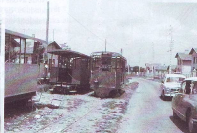
L'automotrice en chantier à la station de Meyzieu en juin 1962. Clichés J.J. Doërflinger
